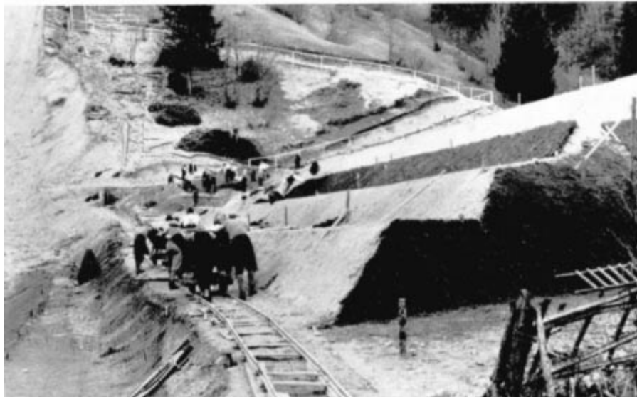
Tribünen werden aufgeschüttet
