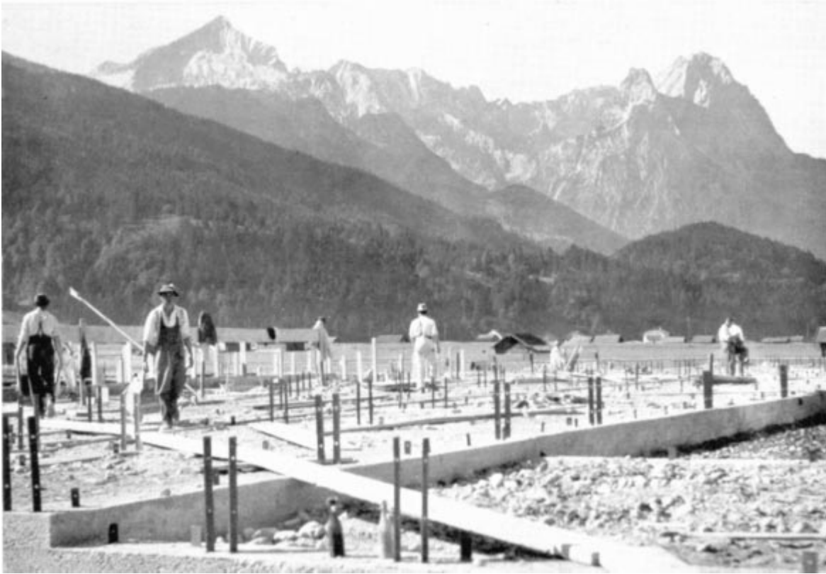
Am 1. August 1934 wurde mit dem Bau des Olympia-Kunsteisstadions begonnen
