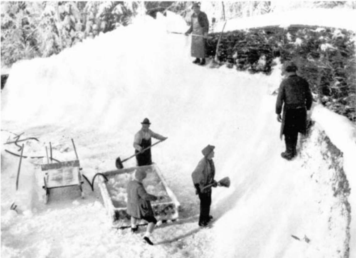
Ausmauerung der Bobbahn-Kurven mit Eisplatten und Schnee
