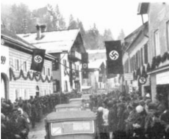
Trotz dieser Menschenmassen ungehinderter Fahrverkehr
