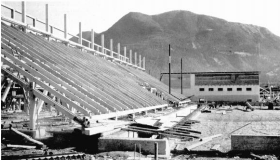
Das Gerüst der Haupttribüne wird errichtet
