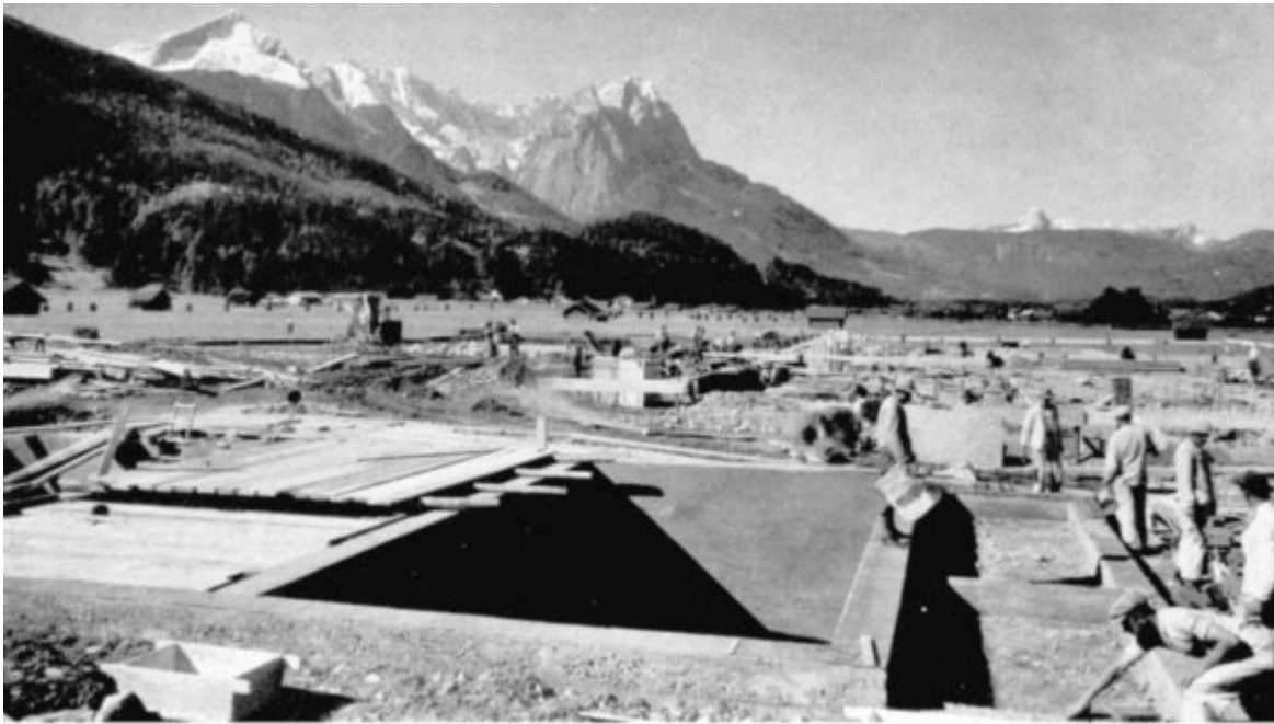
Das Fundament des Maschinenhauses
