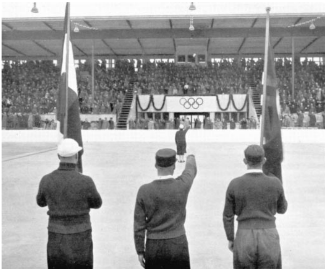
Nach 106 Baulagen, am 16. Dezember 1934, konnte das Olympia-Kunsteisstadion bereits eröffnet werden
