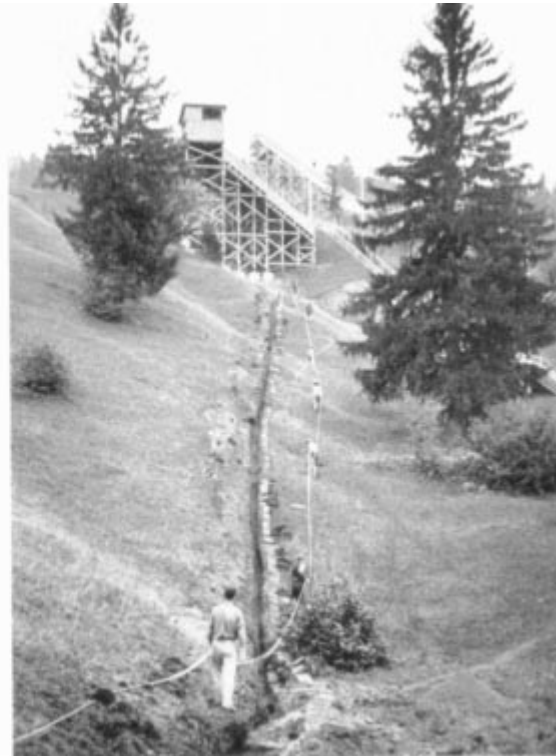
Alle Kabel des internen Nachrichtendienstes wurden verlegt
