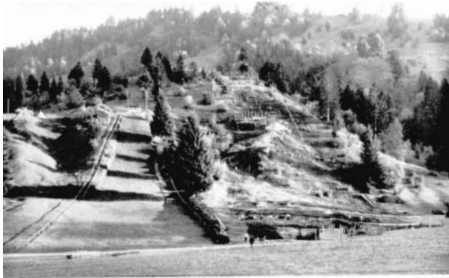
Baubeginn der Großen Olympia-Schanze
