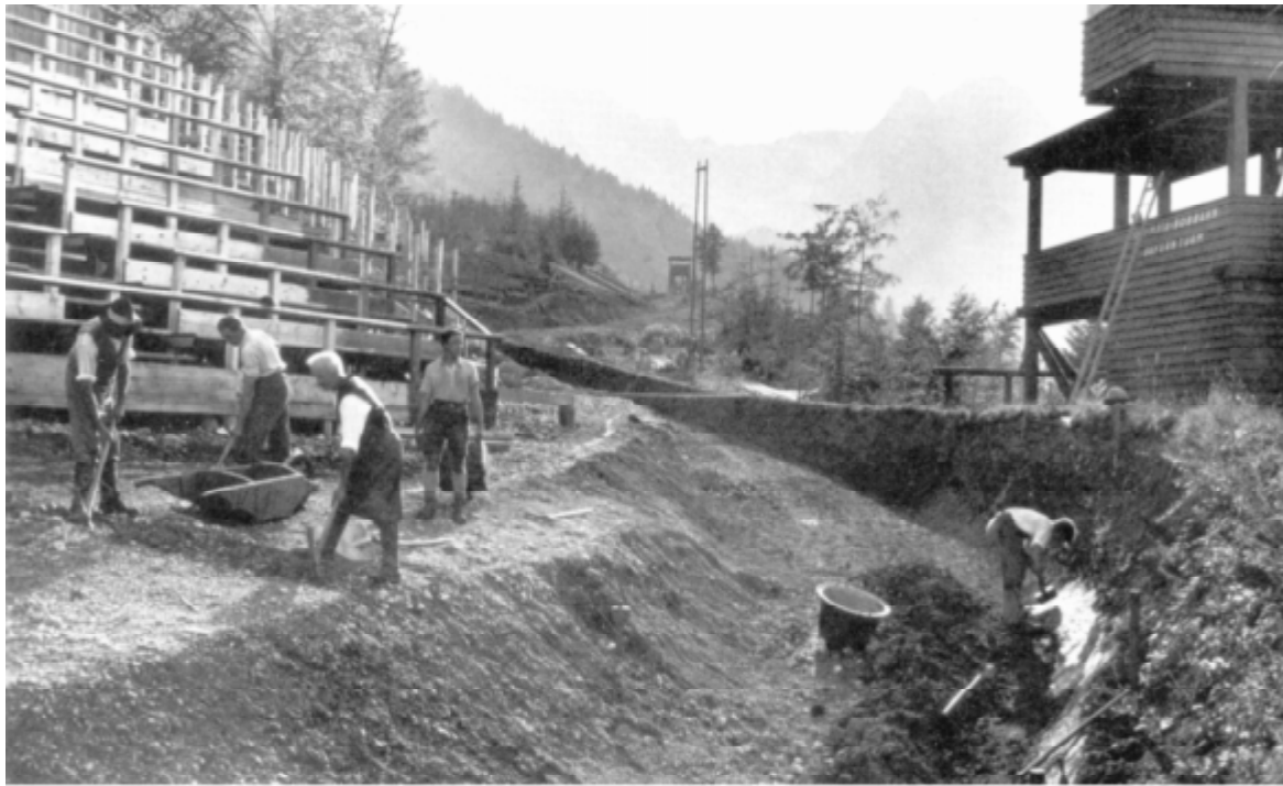
Tribünen im Bau
