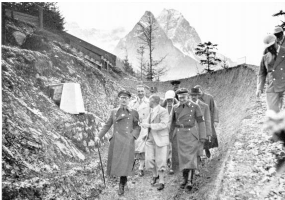
Der Reichssportführer von Tschammer und Osten überzeugt sich von den Baufortschritten an der Olympia-Bobbahn
