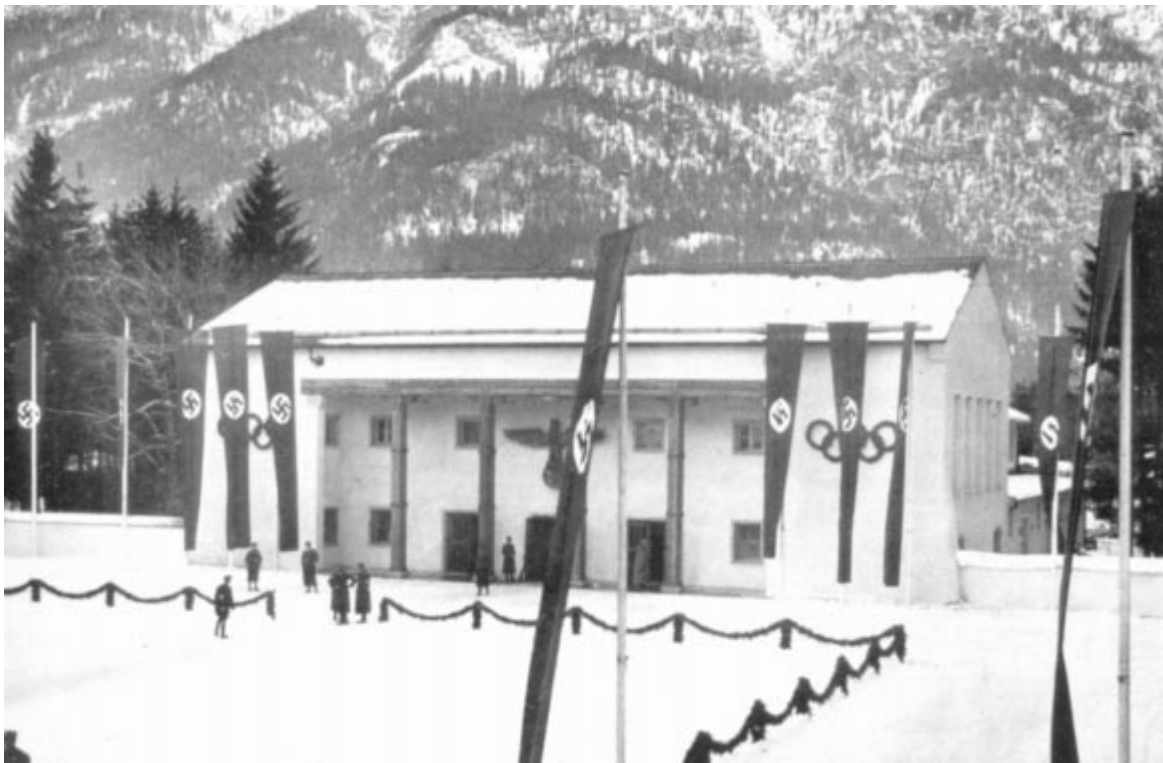
Festsaalbau des Marktes Garmisch-Partenkirchen
