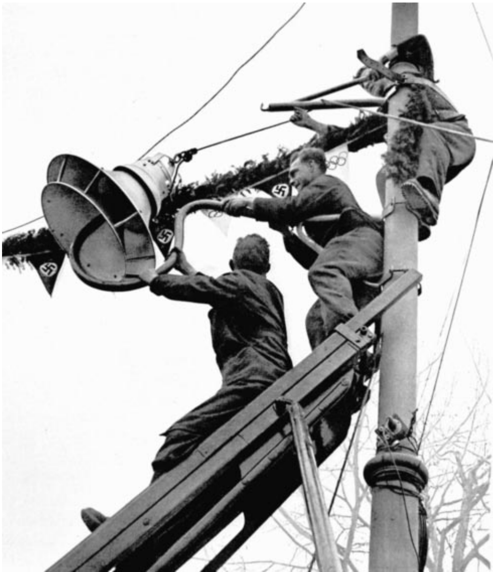
Lautsprecher werden angebracht
