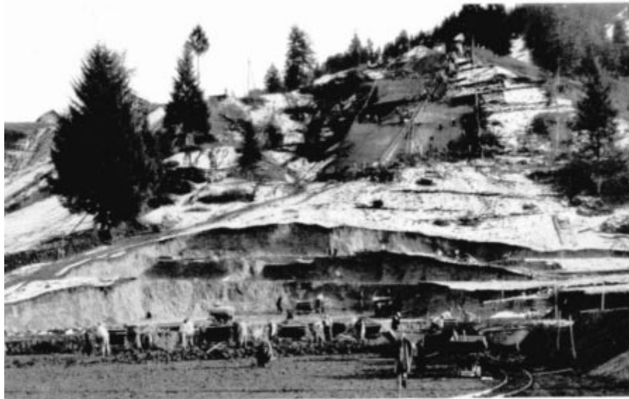
Große Erdbewegungen waren notwendig
